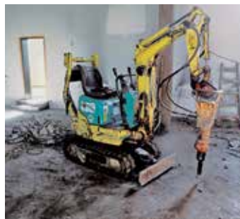
Der bisherige Boden wird herausgerissen, damit die neue Fußbodenheizung verlegt werden kann.
