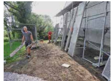
Auch an der Nordseite ist ein Gerüst notwendig, damit der Lichtschlitz geschlagen werden kann.
